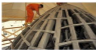
من الناحية المعمارية فإن القبة التي على السبيل ليست قبة حنبلية ولكنها هيكل خشبي مزوج على شكل قبة
